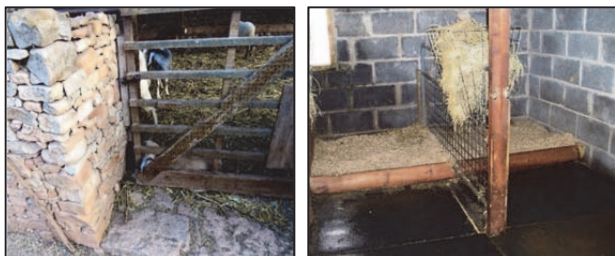
شکل ۱۶- استفاده از بلوک سیمانی (راست) و استفاده از سنگ (چپ) برای ساخت جایگاه پرورش گوسفند و بز
