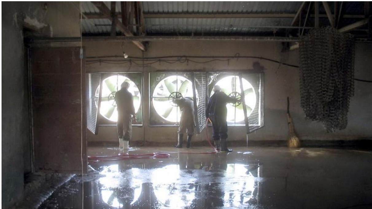
شکل ۱: عملیات شستشوی هواکش‌ها
